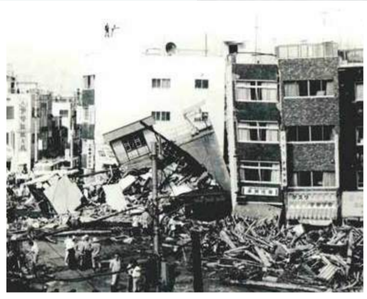
宇治川商店街のビル倒壊と流木の堆積状況（神戸市中央区）
