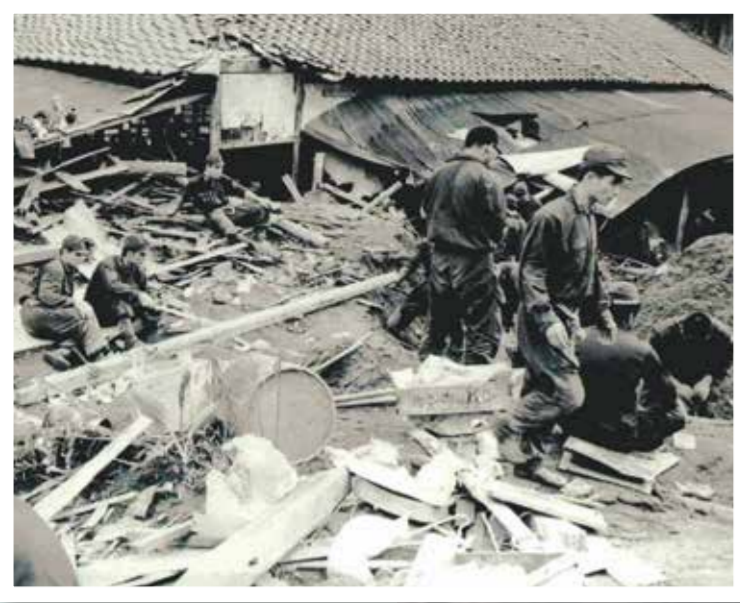
崩壊土砂により埋没した家屋からの救命作業（神戸市長田区明泉寺町）
