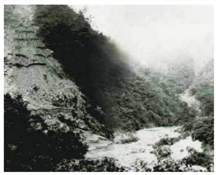
岩屋堰堤上流右岸の山腹崩壊状況（神戸市兵庫区里山町）
